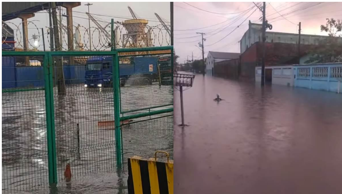
Figura 6 - Alagamento no entorno do Porto de Paranaguá
