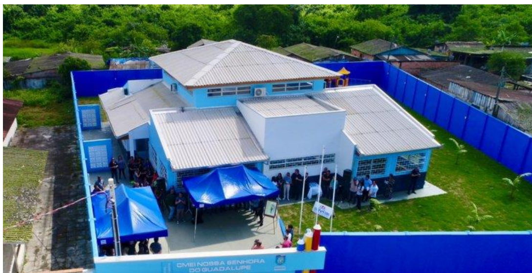
Figura 23 - Vista de cima do Centro Municipal de Educação Infantil
