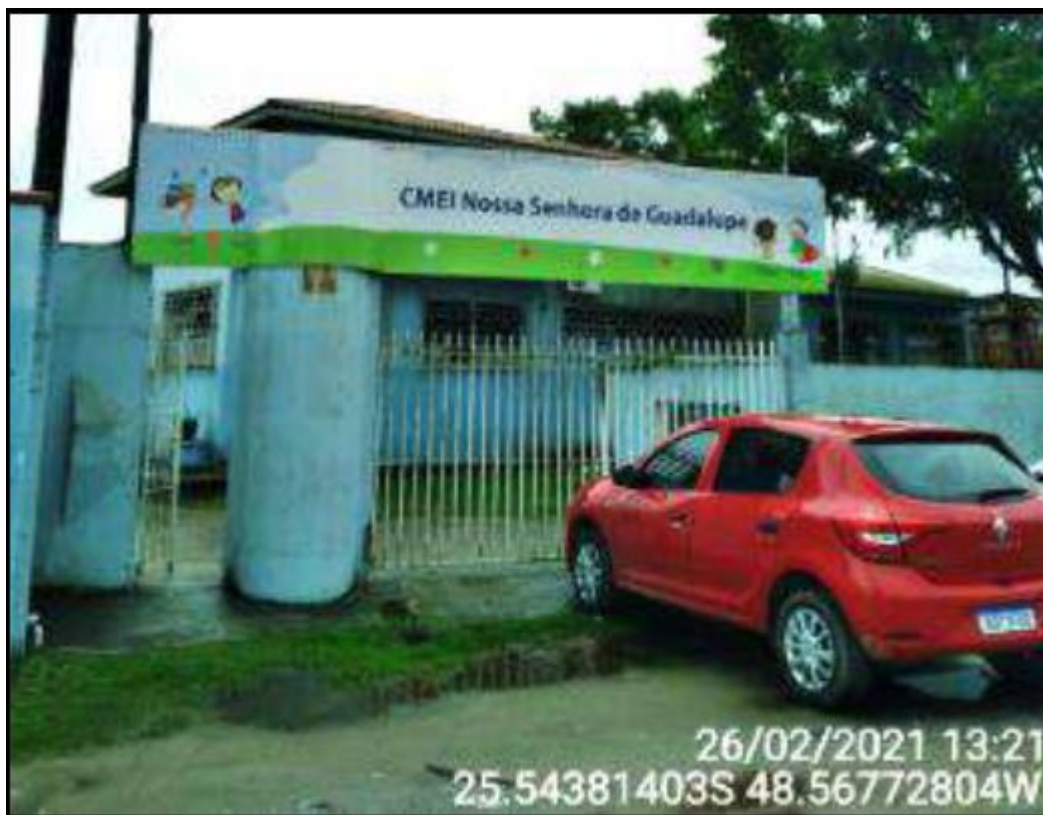
Figura 22 – Centro Municipal de Educação Infantil antes da reforma
