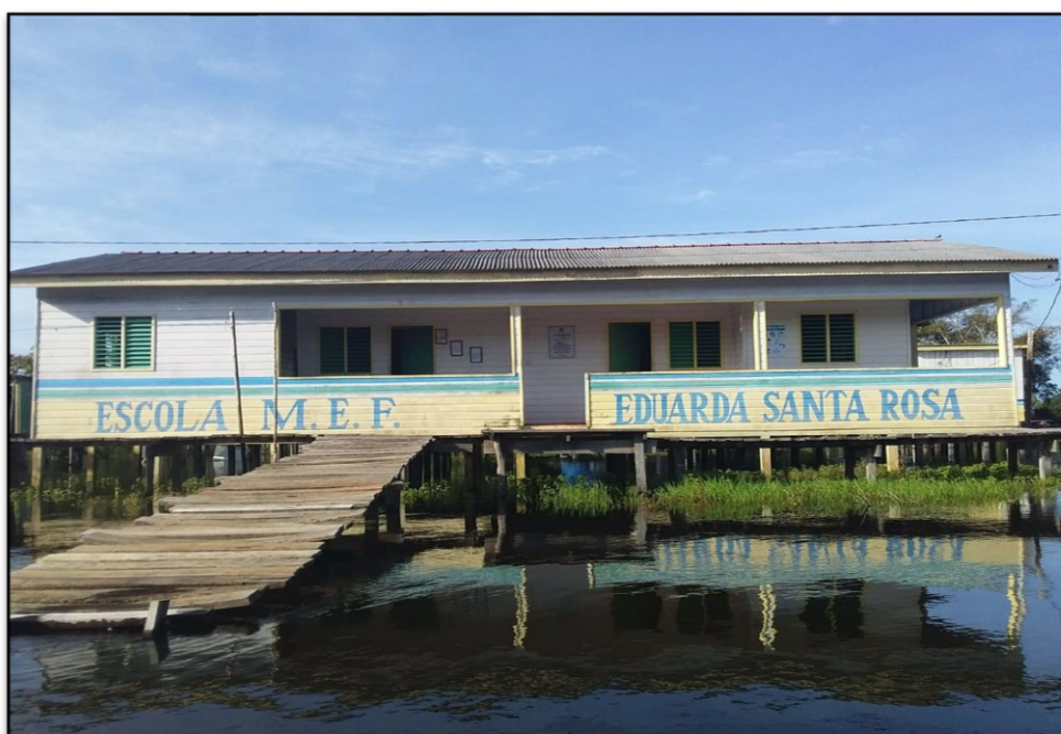
Figura 27 – Fachada da Escola Municipal do Campo Eduarda Santa Rosa
