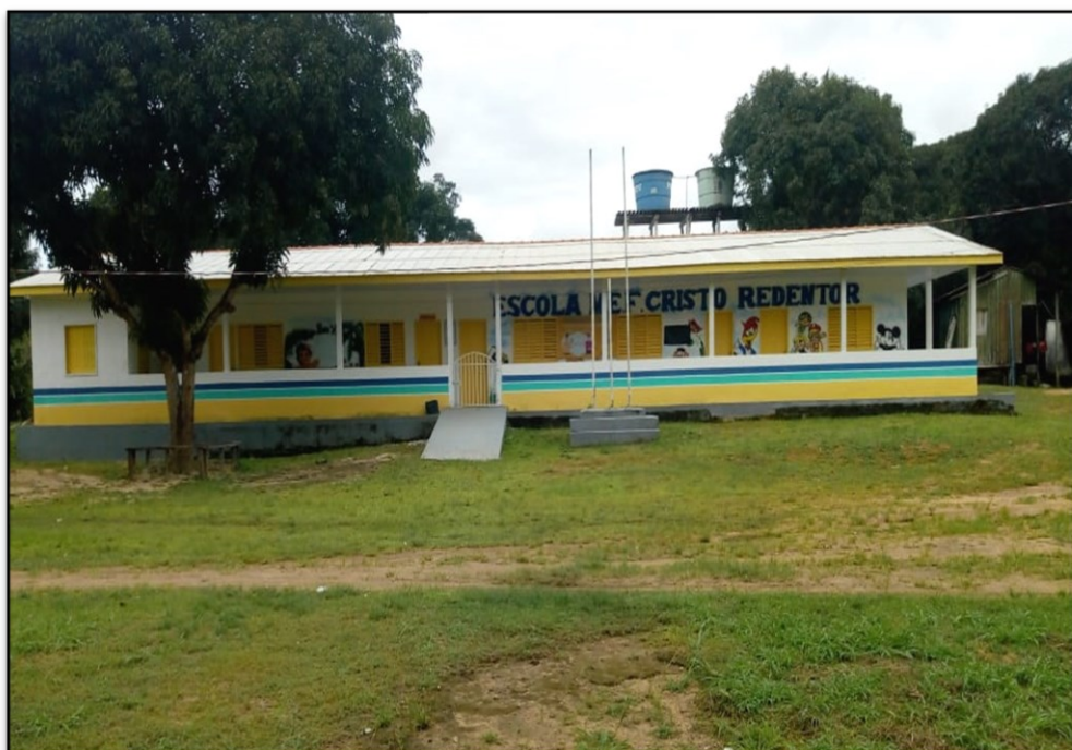
Figura 25 – Fachada da Escola Municipal do Campo Cristo Redentor
