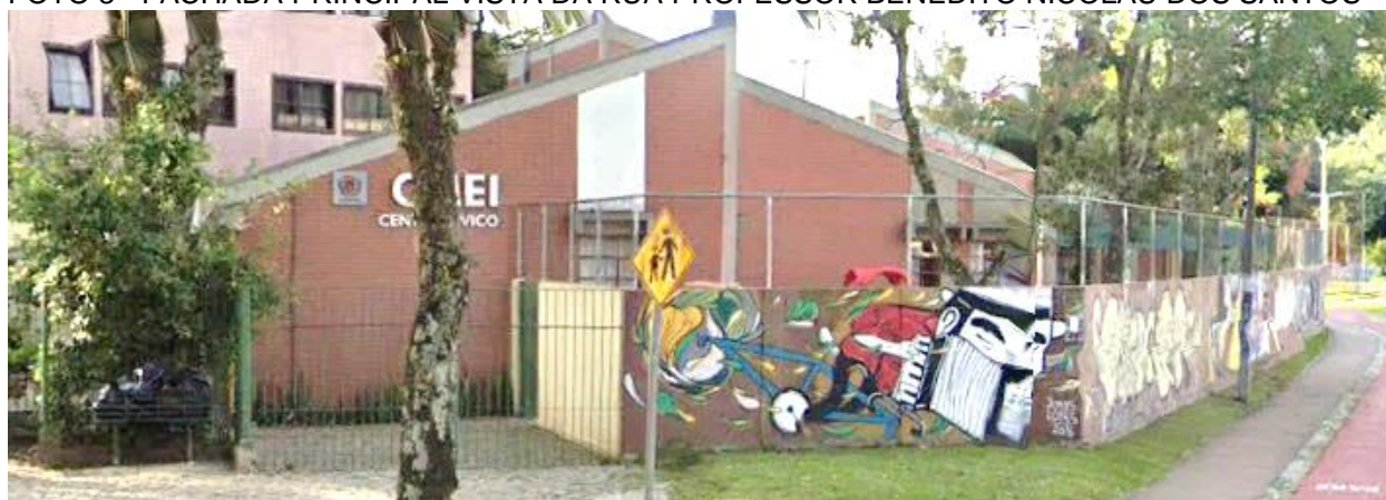
FOTO 3 - FACHADA PRINCIPAL VISTA DA RUA PROFESSOR BENEDITO NICOLAU DOS SANTOS
