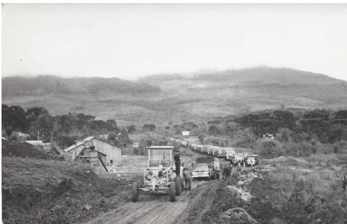
IMAGEM 3 - A ORGANIZAÇÃO DO ESPAÇO DE ENTRE RIOS PARA ABRIGAR AS FAMÍLIAS DOS IMIGRANTES SUÁBIOS
