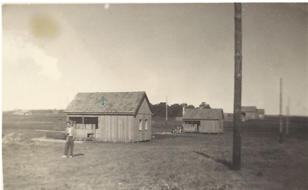
IMAGEM 4 - PRIMEIRAS CASAS CONSTRUÍDAS
